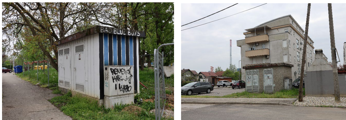
Slika 15. Trafostanice u Ulici N. i B. Bionde [1] i Letovaničkoj [2]
